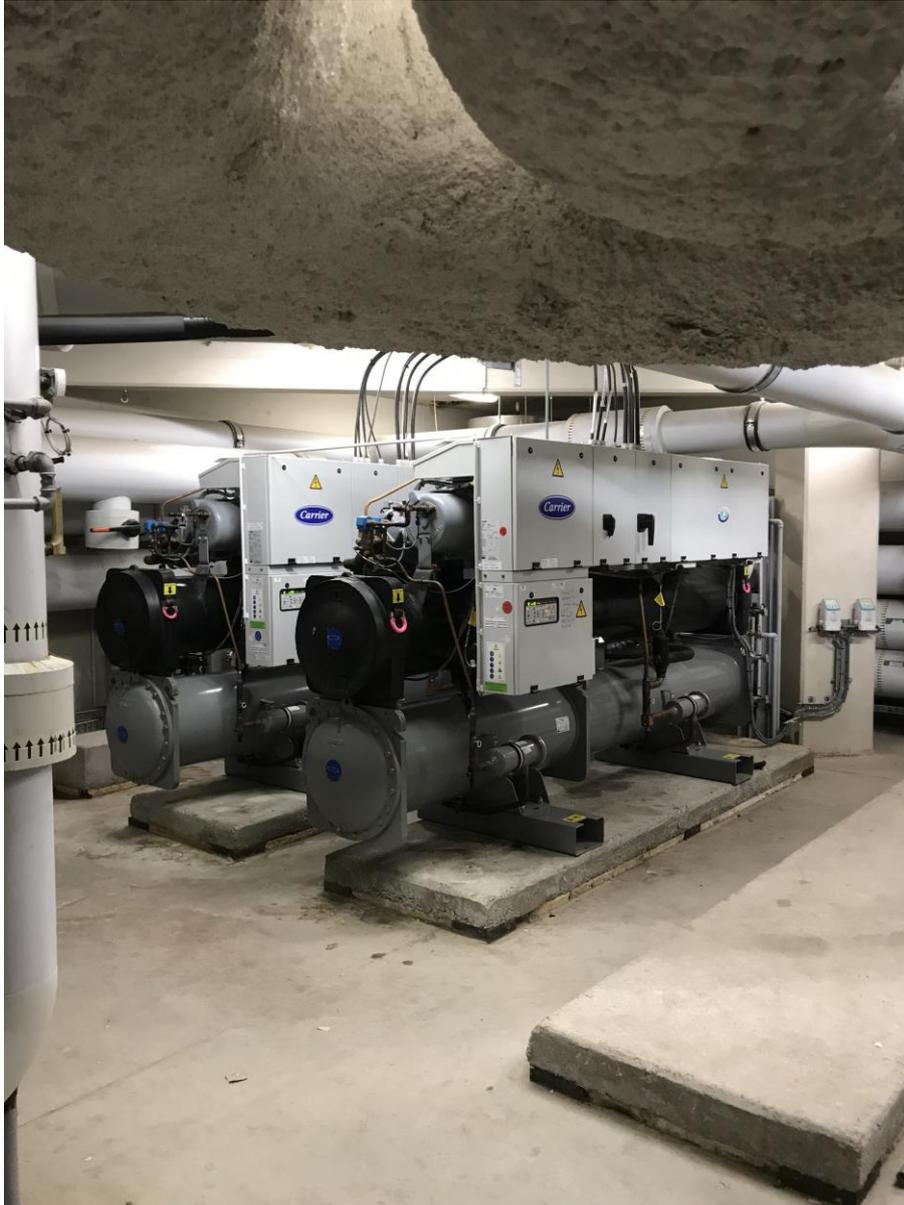
Les groupes froids dont font l'objet le présent marché alimentent l'ensemble du bâtiment, par conséquent et si des coupures sont nécessaires, un phasage devra être mis en œuvre afin de toujours garantir une alimentation en eau glacée du site.
