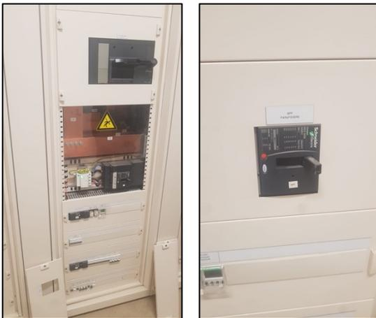
Présence d'un parafoudre type 1 triphasée conforme.
