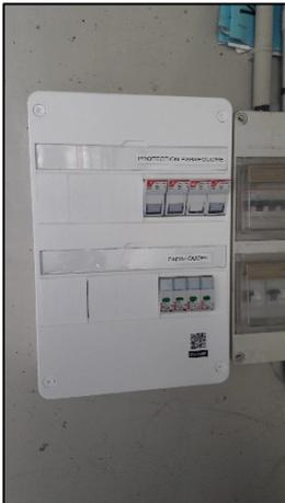
L'armoire SSI est équipée d'un parafoudre type 2 triphasée qui est une protection correcte.
